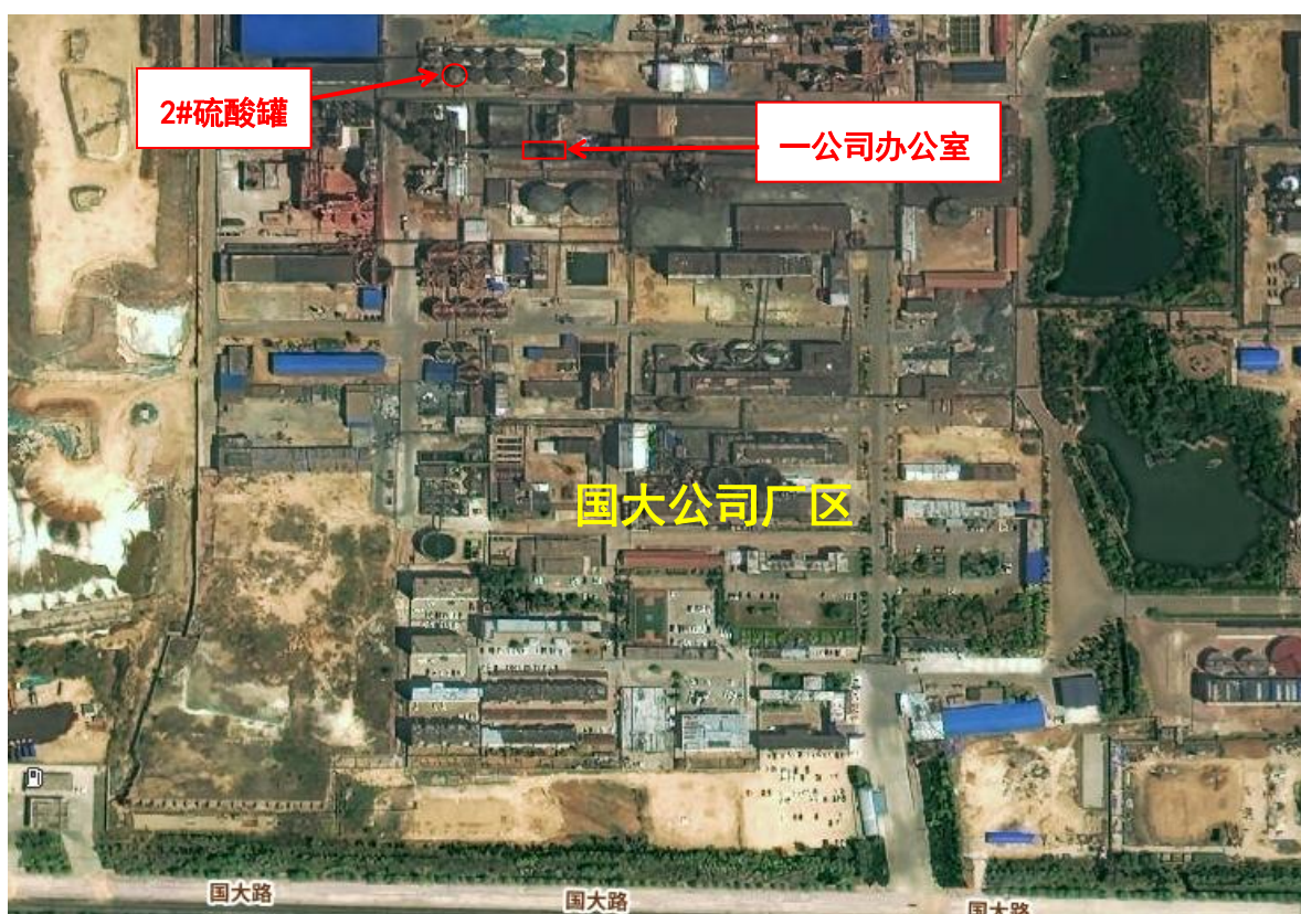
图 3 2#硫酸罐、—车间办公室方位图
