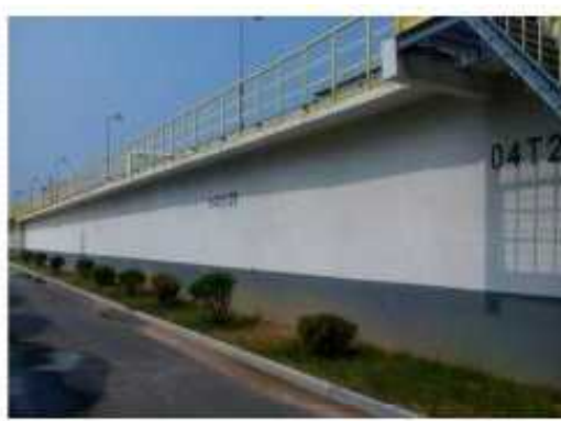
污水站事故水池
