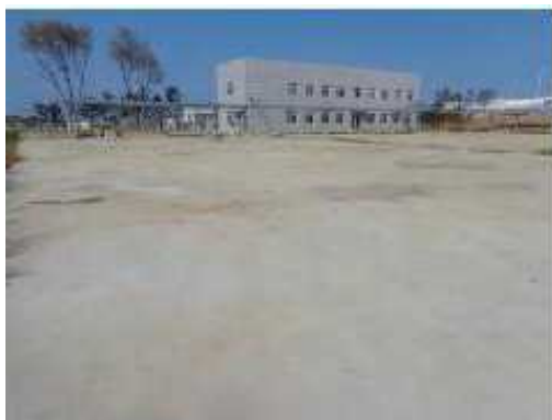
消防事故水池
