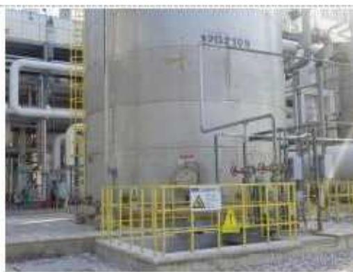
装置区围堰及污水收集池
