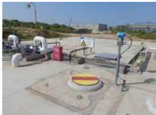
装置区初期雨水池
