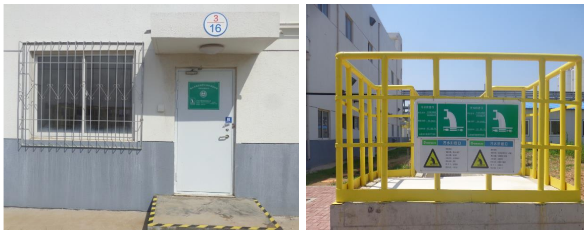
图 15.3-2 现有排污口及在线监测小屋
