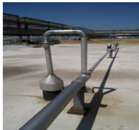
污水处理系统、污水池废气收集设施
