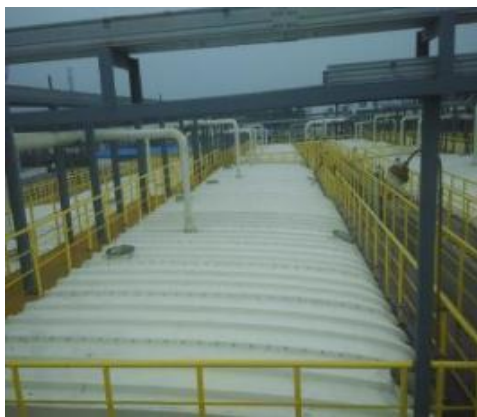
污水处理系统、污水池废气收集设施
