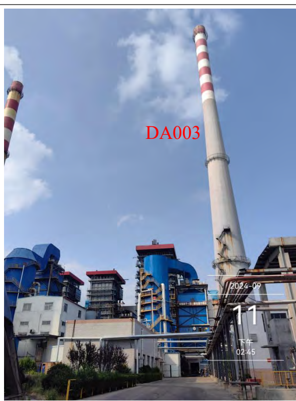
锅炉烟囱 DA003
