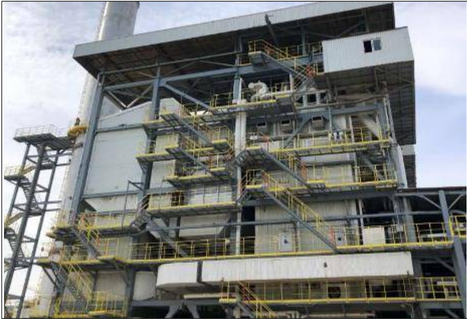
图2.2-12 废能锅炉外貌图
