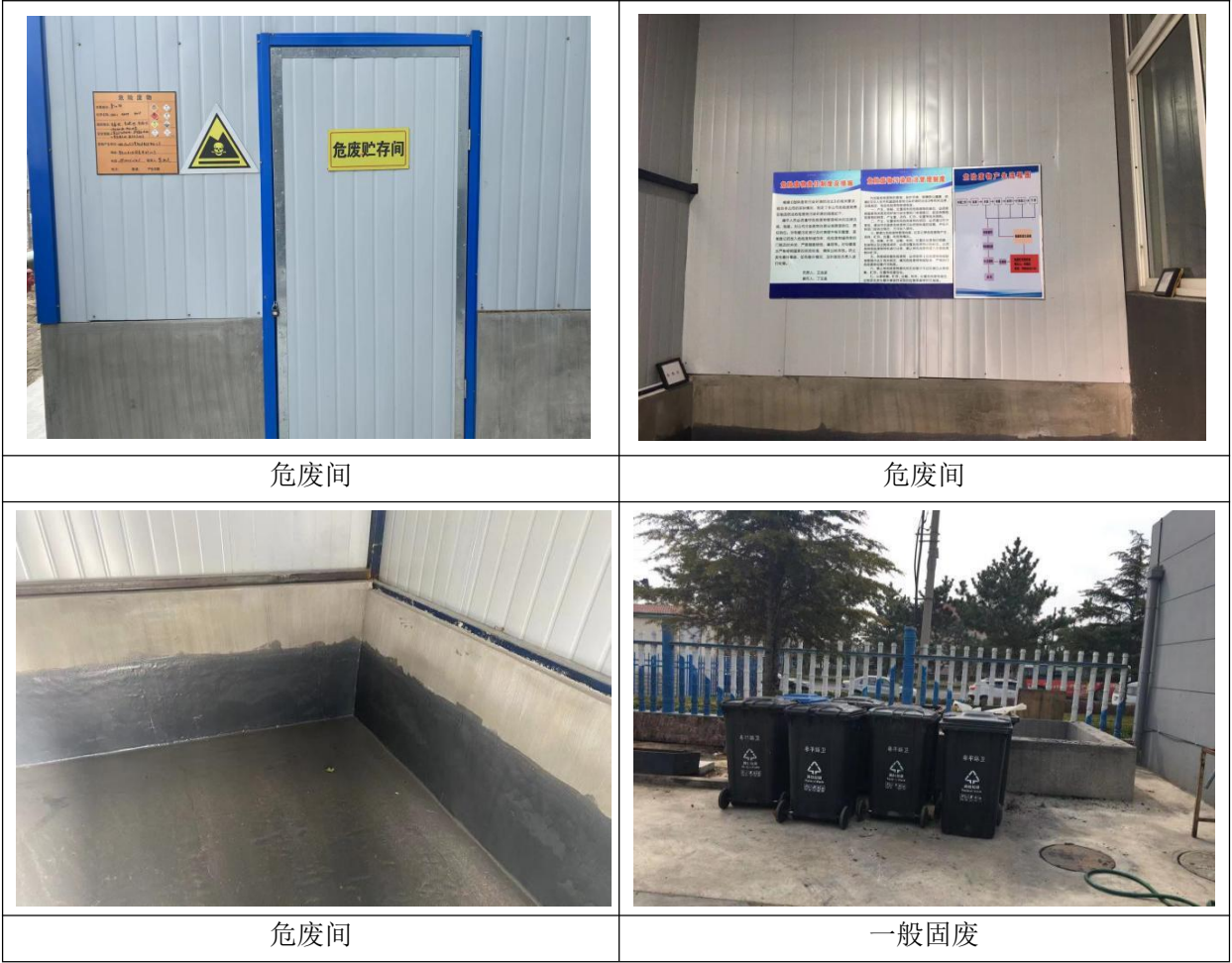
图 2.2-13 公司固废处理设施照片
