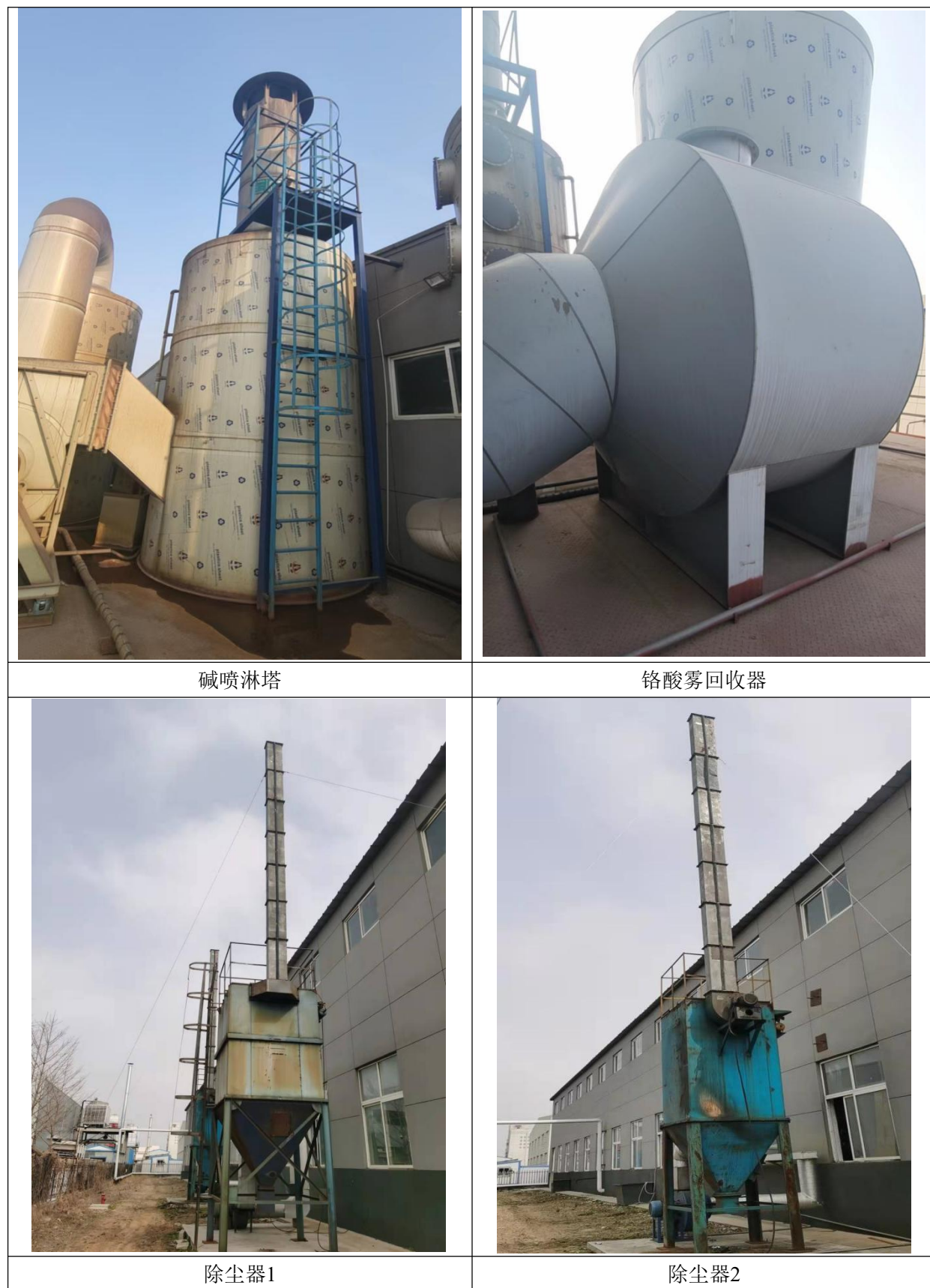
图 2.2-10 公司废气处理环保设施
