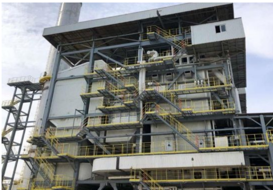
图 3.2-2 废能锅炉外貌图
