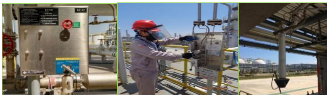
图 3.2-5 密闭采样器密闭采样装车密封
