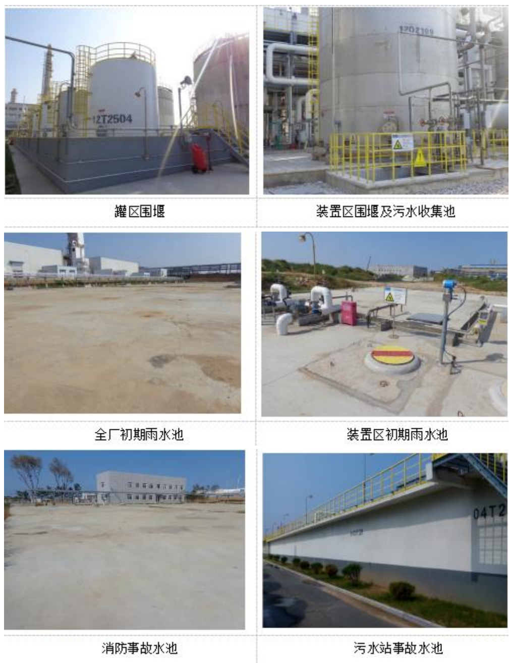
图 7.1-2 现有工程水环境风险防范设施
