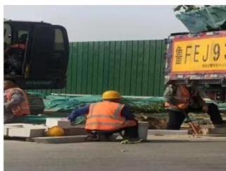
坚守在工作岗位上的修路的工人
