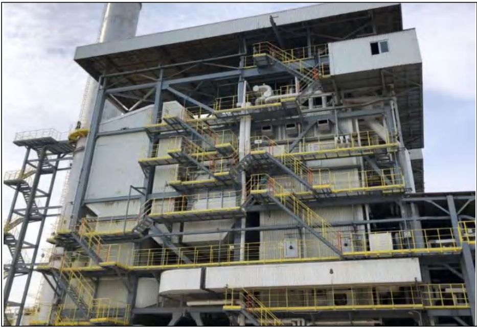
图 2.2-2 废能锅炉外貌图
