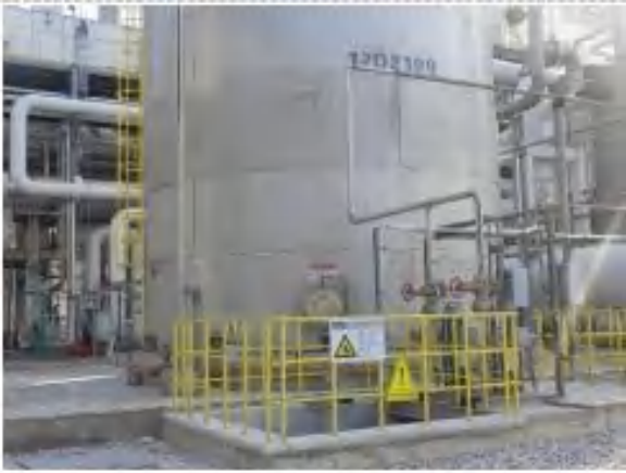
装置区围堰及污水收集池
