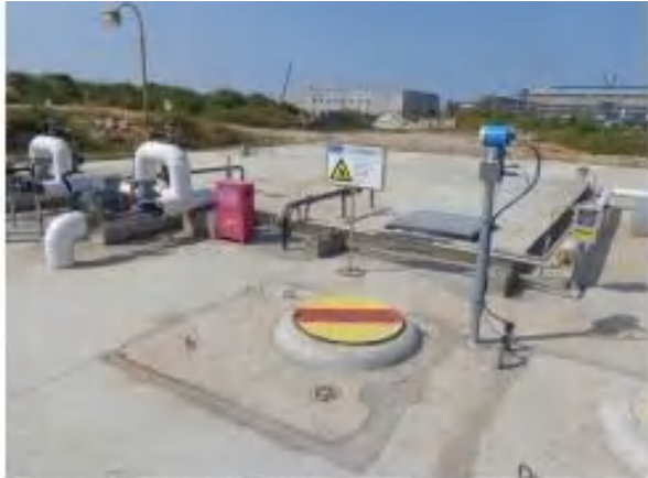
装置区初期雨水池
