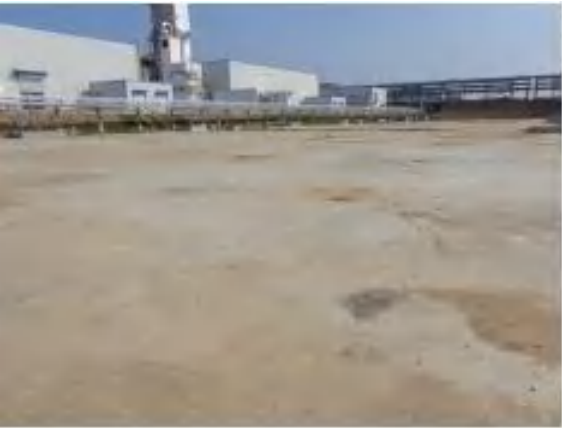
全厂初期雨水池
