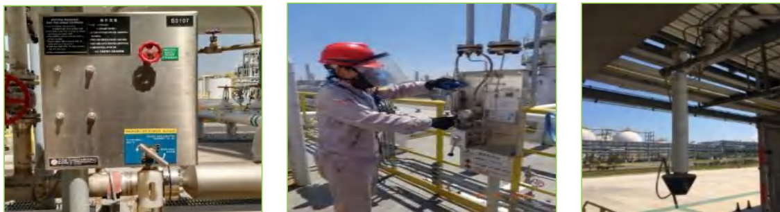
图 2.2-6 密闭采样器密闭采样装车密封
