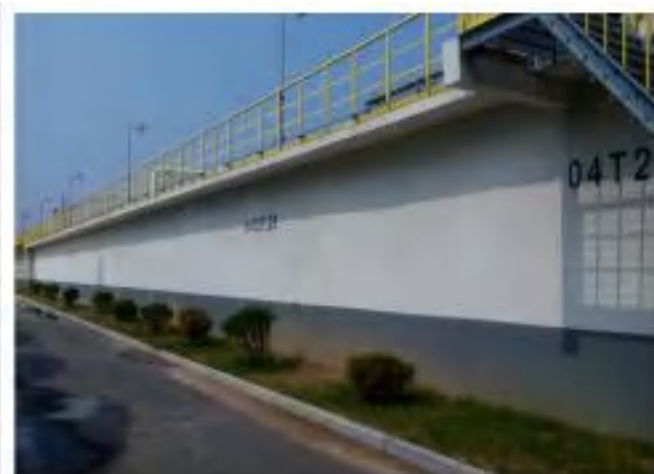
污水站事故水池
