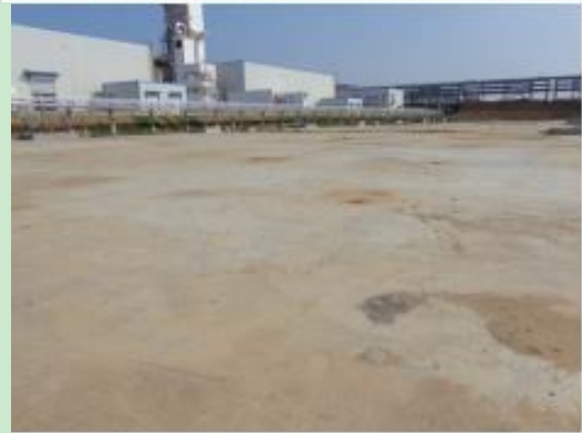
全厂初期雨水池
