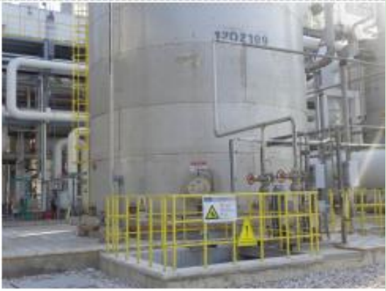
装置区围堰及污水收集池
