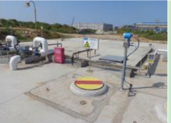
装置区初期雨水池
