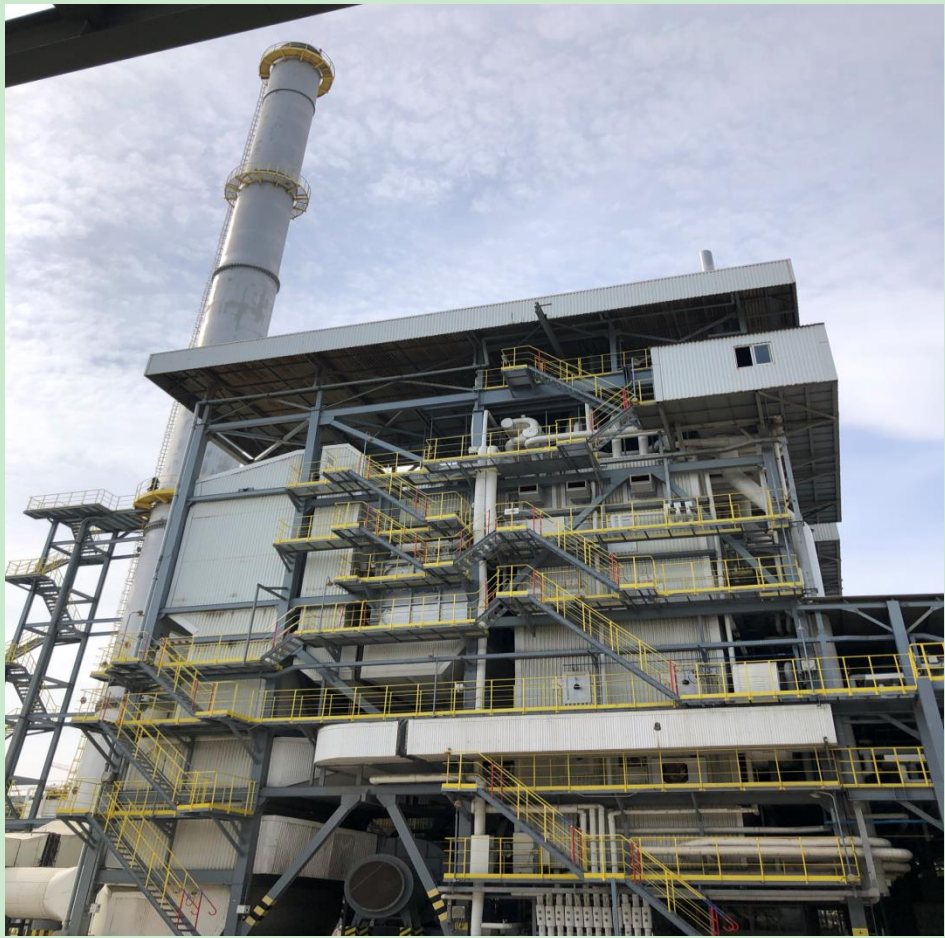
图 2.2.5-1 废能锅炉现状照片
