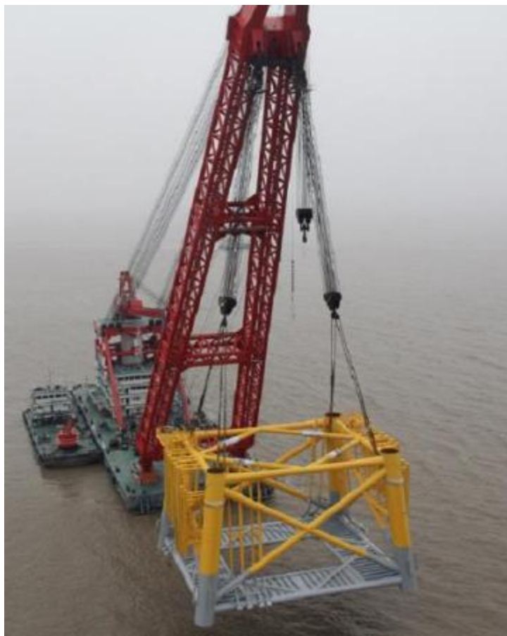
图 3.8-5 海上升压站导管架沉放示意图
