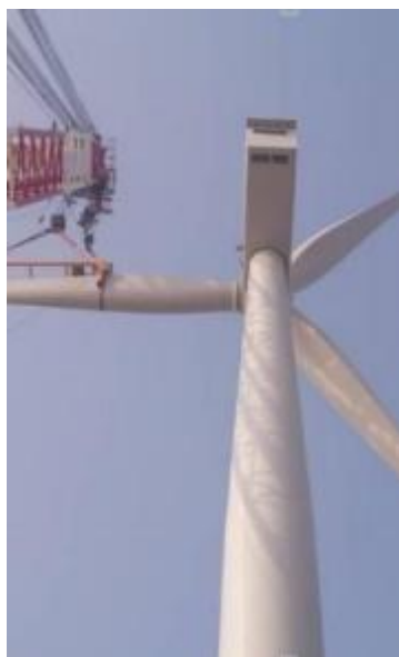
图 3.8-4 叶片吊装图
