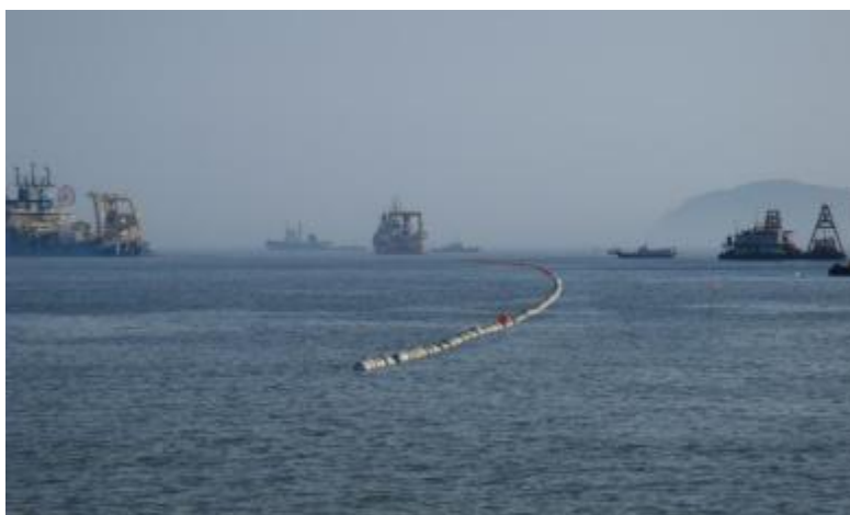
(b) 海缆绑扎泡沫浮筒敷设示意图
