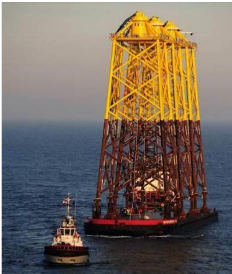
图 3.8-1b 导管架运输
