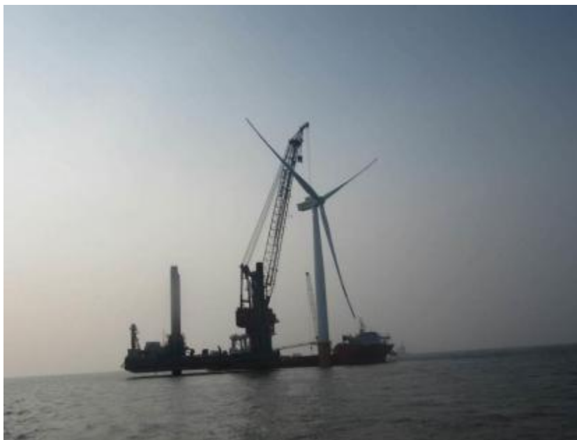
图 3.8-3 自升式船舶进行风机安装
