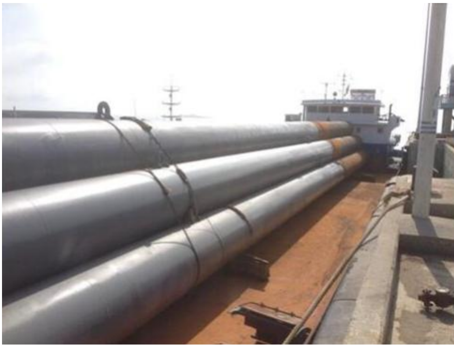
图 3.8-1a 钢管桩运输实景
