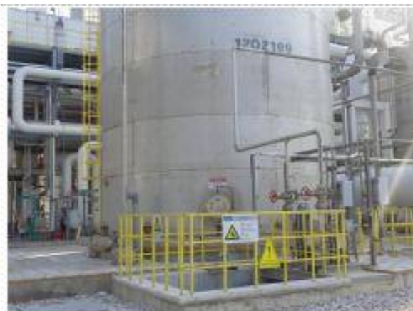
装置区围堰及污水收集池
