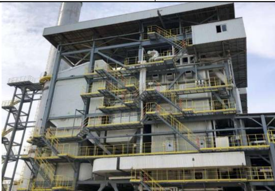
图 3.2-2 废能锅炉外貌图
