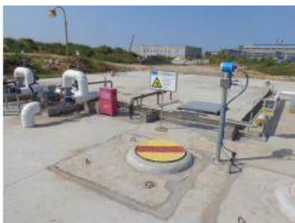
装置区初期雨水池
