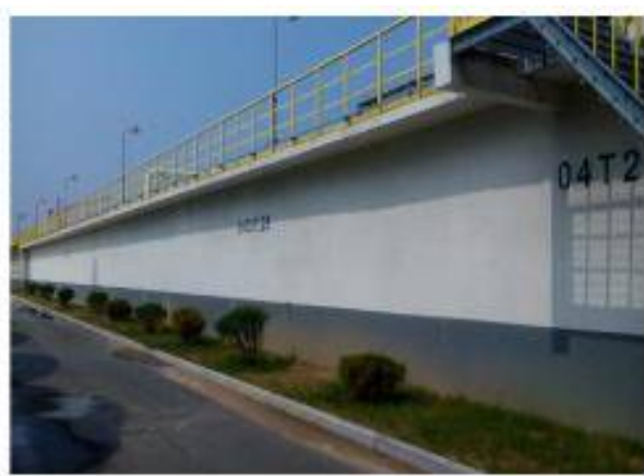
污水站事故水池
