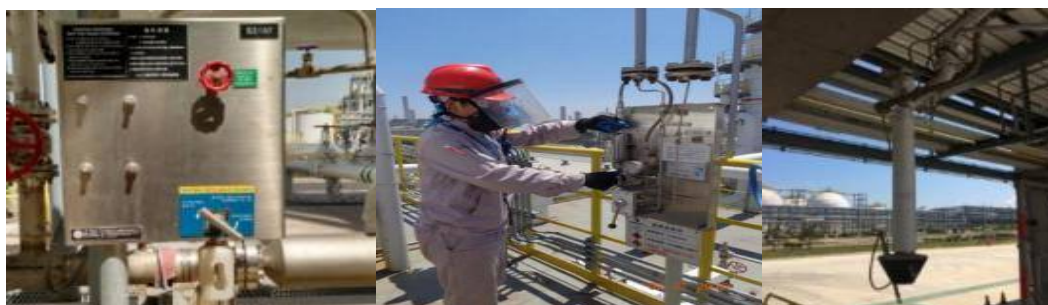
图 3.2-6 密闭采样器密闭采样装车密封
