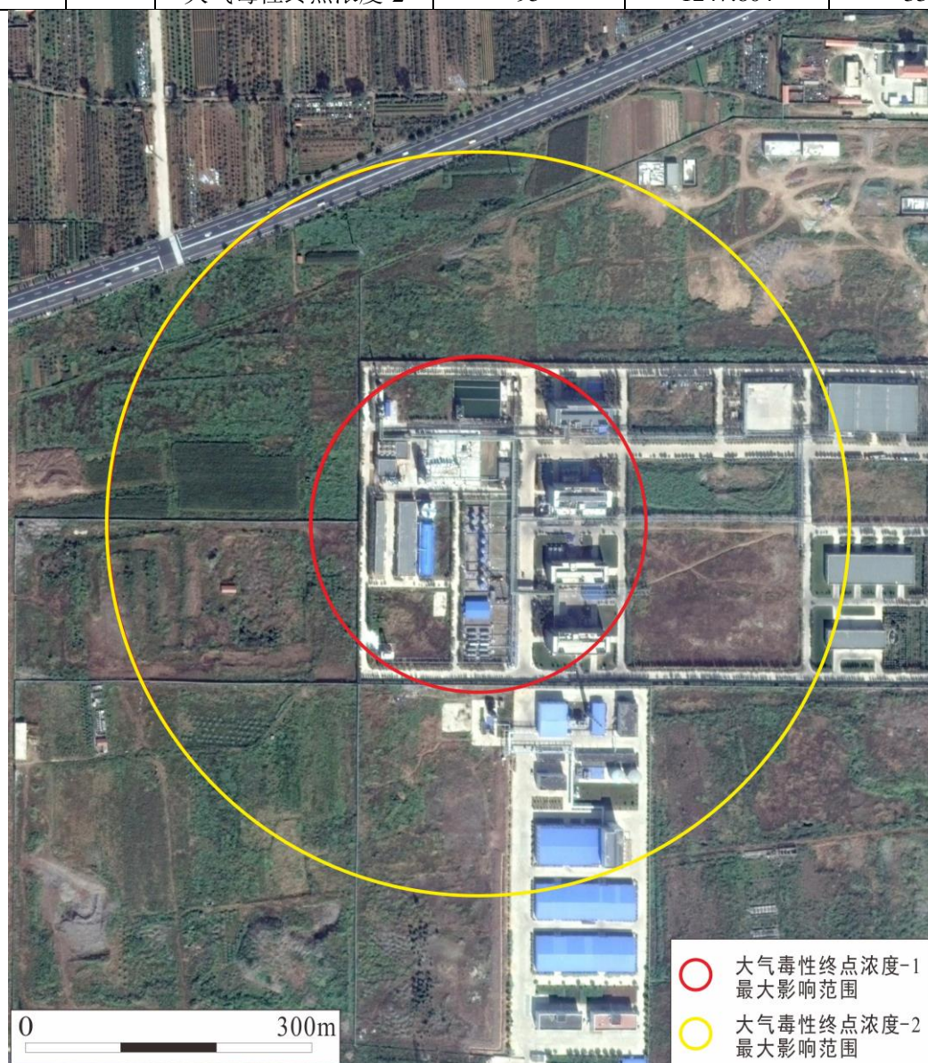
图 10.7-5 醋酐储罐泄露发生火灾事故时次生 CO 最大影响范围图(最常见气象)
